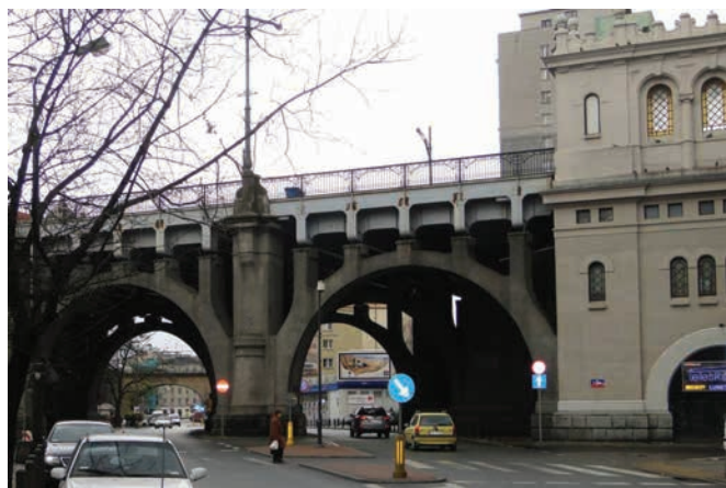
Fot. 2. Przejazd nad ul. Solec widziany od strony południowej.
