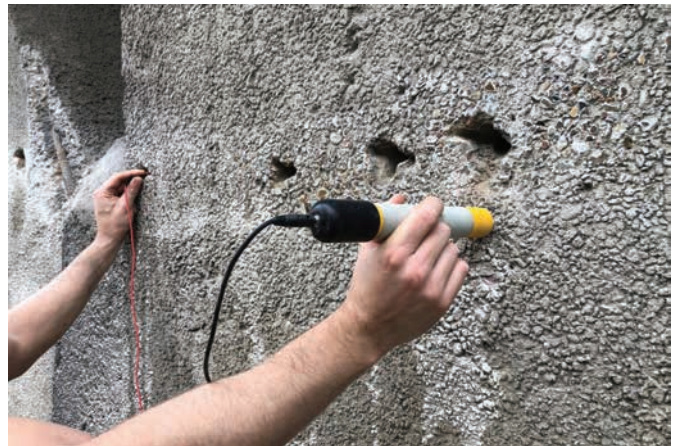
Fot. 6. Badanie potencjału korozyjnego na powierzchni filara.
