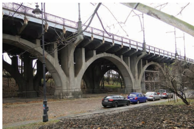
Fot. 1. Widok ogólny od strony południowej pierwszej części wiaduktu (od osi 1 do 10).
