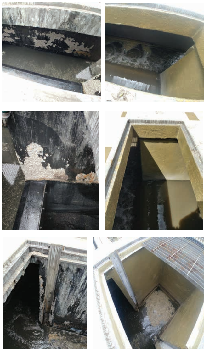
Rys. 9. Stan techniczny ścian zbiorników przed naprawą oraz po jej wykonaniu Fig. 9. Technical condition of tank walls before and after the repair
