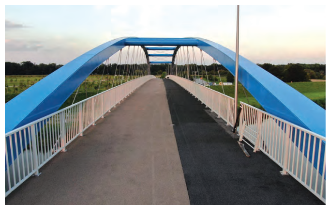
Fot. 6. Kładka pieszo-rowerowa (izolacja-nawierzchnia Prembit)
