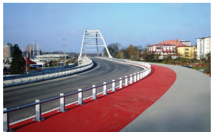
Fot. 5. Izolacja-nawierzchnia na bazie żywicy epoksydowo-poliuretanowej Prem EPU
