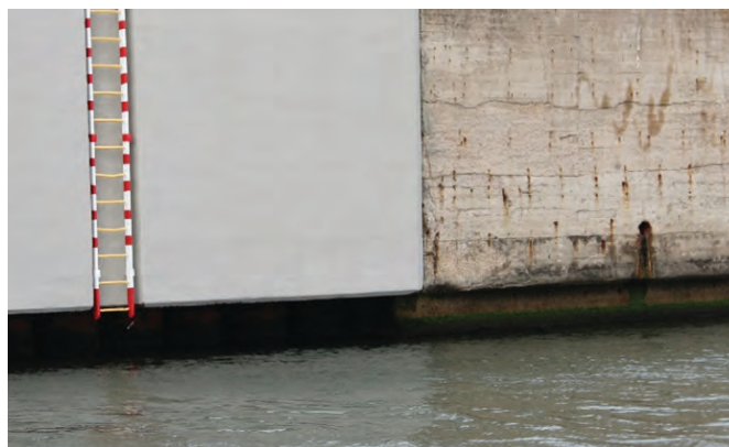
Fot. 2. Fragment pirsu przed i po remoncie (zaprawy MIX1, MIX 2, powłoka polimerowo-cementowa Prem-Cem)
