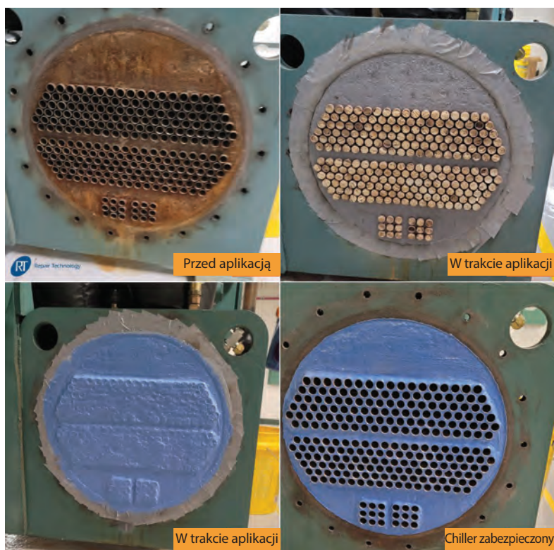
Fot. 4. Technika obudowy i zabezpieczania przeciwkorozyjnego dna sitowego kompozytami Belzona®
