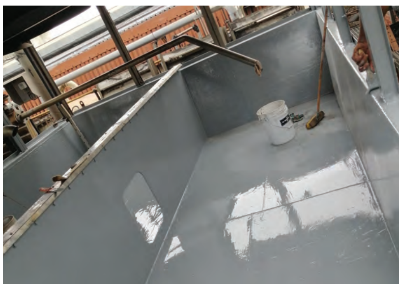
Fot. 8. Wanna ociekowa (basen) wieży chłodniczej zabezpieczona powłoką Belzona® 5811
