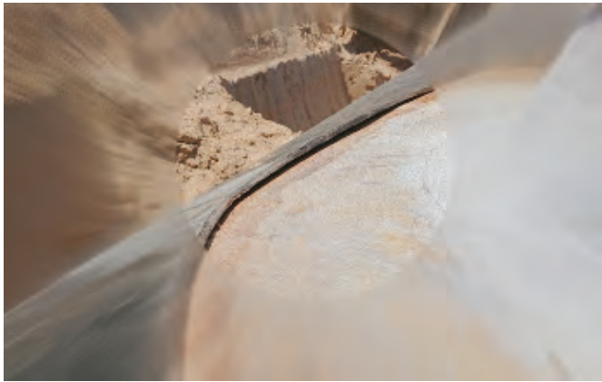
Rys. 20. Przykład odspojenia powłoki 3LPE
