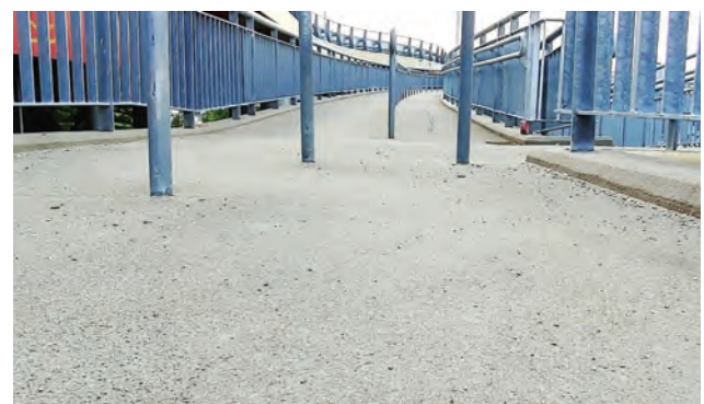
Fot. 1. a, b. Izolacyjno-nawierzchnia na wiadukcie, Warszawa.
