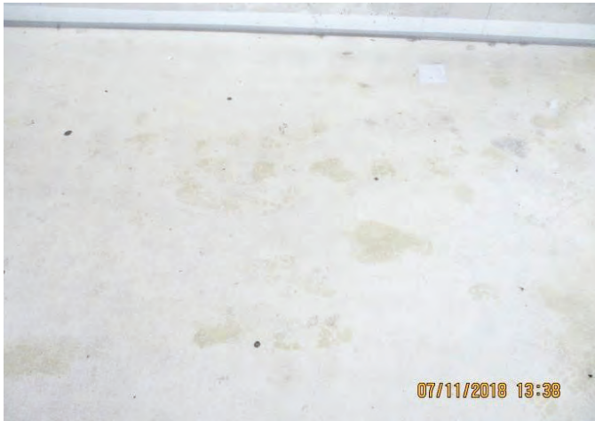
Fot. 8. Niejednorodny wygląd powierzchni posadzki żywicznej. Fot. 8. The heterogeneous appearance of the resin flooring surface.
