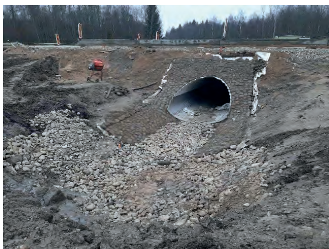
Fot. 3 b. Przepust po zakończeniu prac montażowych Phot. 3 b. Culvert after assembled.
