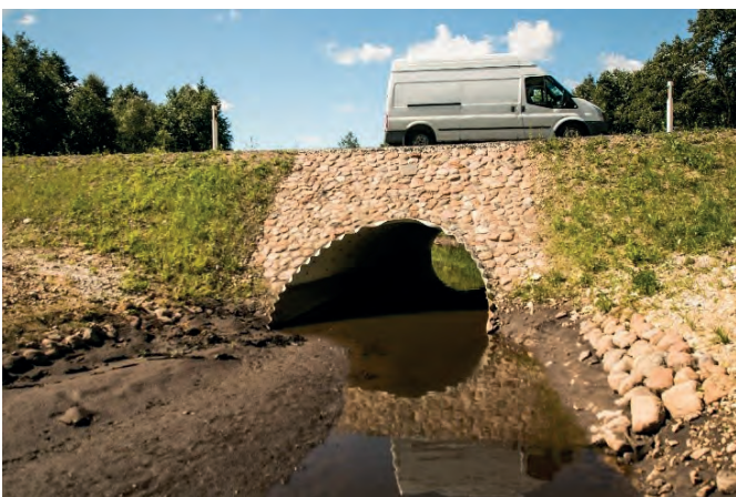
Fot. 4. Konstrukcja po około roku eksploatacji Phot. 4. Culvert after one year of work.
