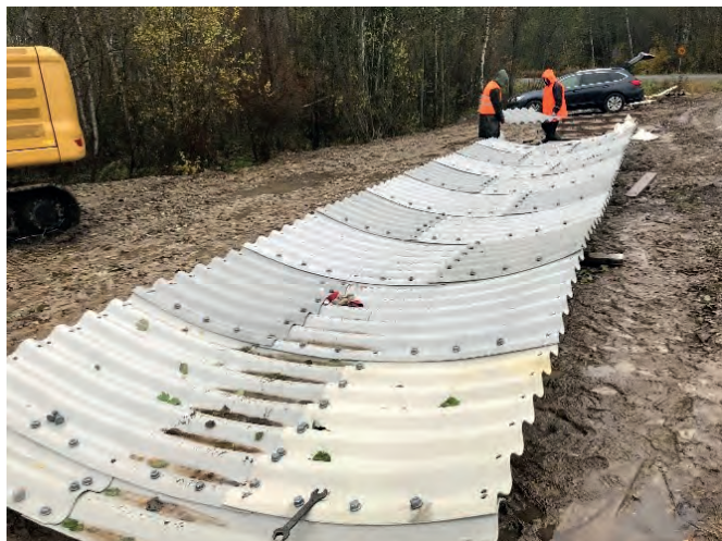
Fot. 3 a. Przepust podczas prac montażowych Phot. 3 a. Culvert during assembly work
