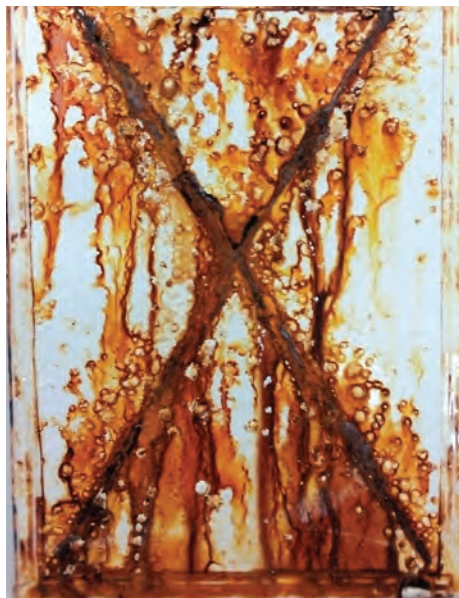
Fot.1. Przykład powierzchni spęcherzonej (ISO 4628-2) oraz zardzewiałej (ISO 4628-3)
