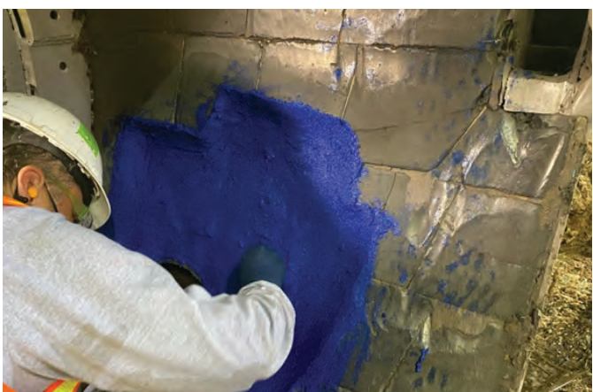
Fot. 7. Wypełnienie ubytków po płytach trudnościeralnych miksera kompozytem trudnościeralnym Belzona®1818
