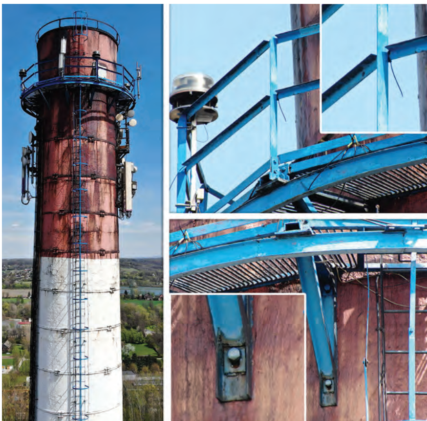
Zdjęcie górnej galerii komina o wysokości 220 m.
