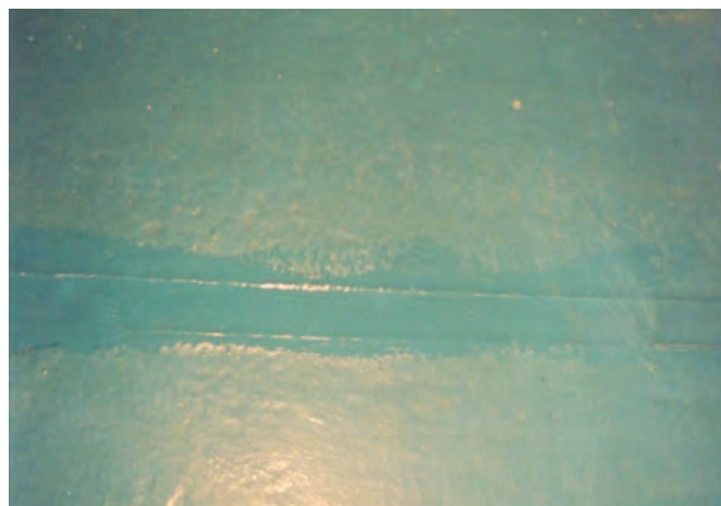
Fot. 7, 8. Zabezpieczenie szczeliny wypełnionej sznurem systemem epoksydowo/poliuretanowym.
