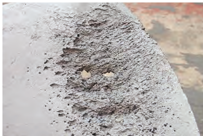
Fot. 2. Wżery z perforacją wywołane erozją kawitacyjną łopatki wirnika pompy
