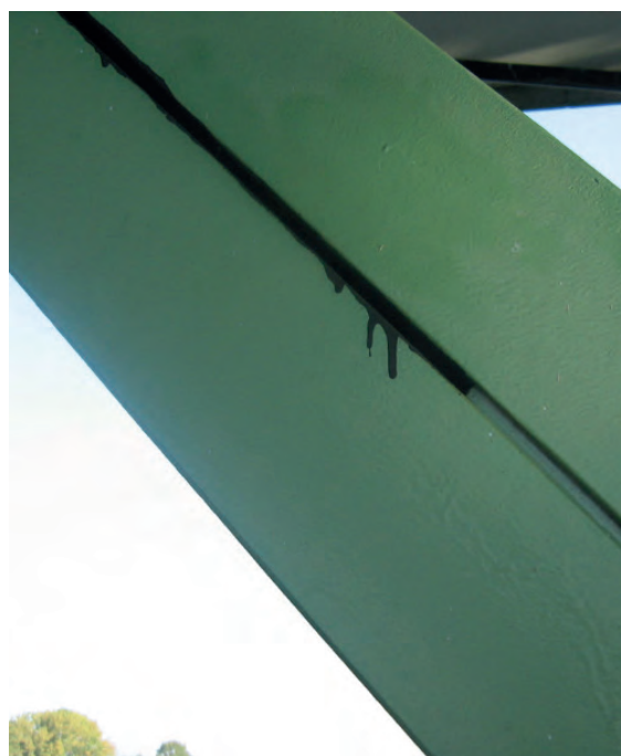
Fot. 6. Zabezpieczenie szczeliny preparatami woskowo-bitumicznymi.
