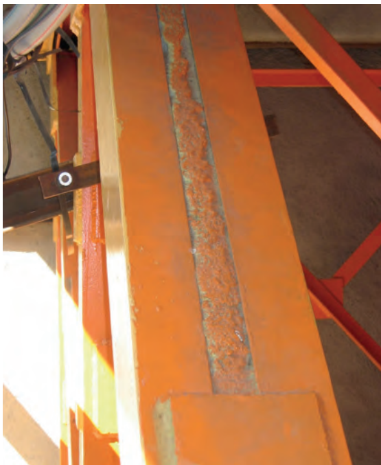
Fot. 9. Zabezpieczenie szerokiej szczeliny betonem modyfikowanym inhibitorem korozji.
