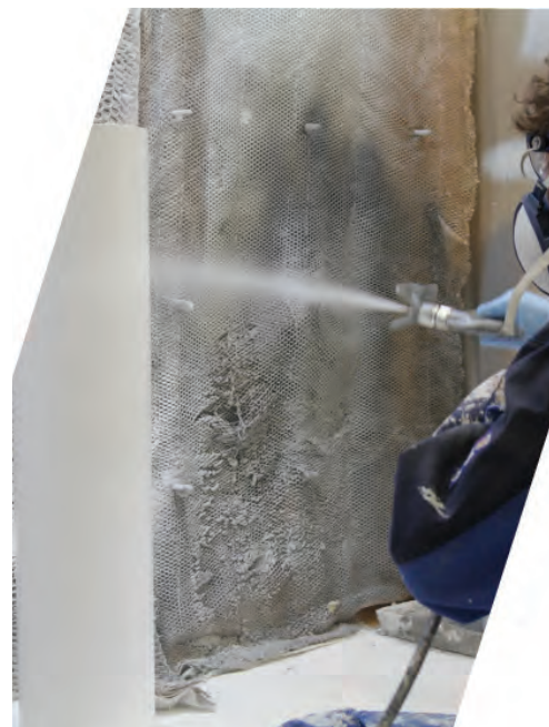
Aplikacja powłoki pęczniącej PPG STEELGUARD
