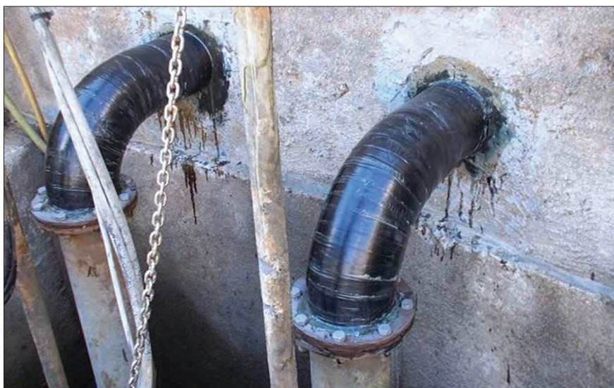
Fot. 5. Wzmocnienie kolan rurociągów stalowych kompozytem Belzona® SuperWrap II
