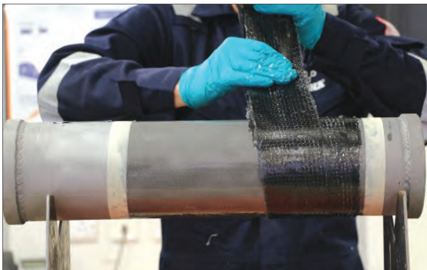
Fot. 3. Wzmocnienia rury stalowej kompozytem Belzona® SuperWrap II
