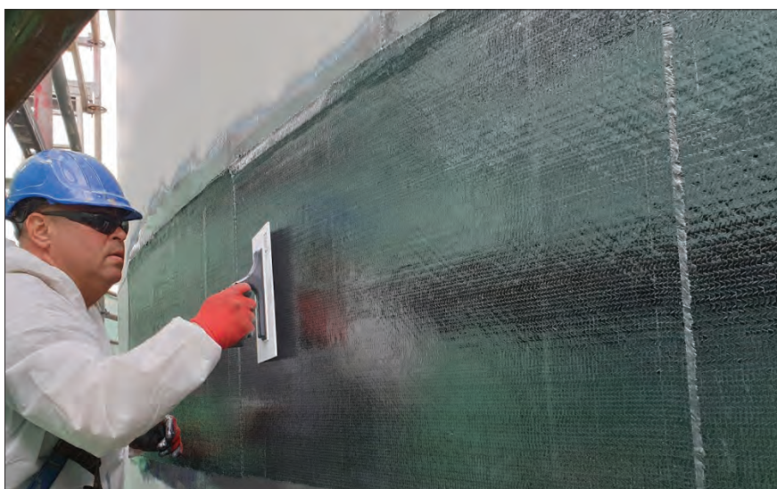
Fot. 4. Wzmocnienia płaszcza stalowego zbiornika solanki kompozytem Belzona® SuperWrap II
