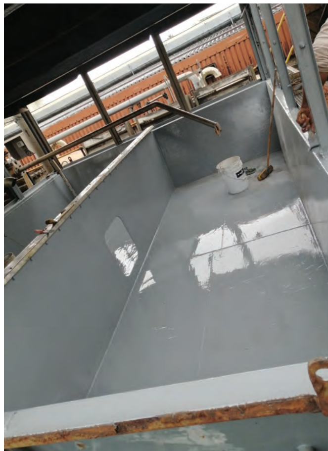
Fot. 4. Wanna ociekowa (basen) wieży chłodniczej zabezpieczonej powłoką Belzona5811
