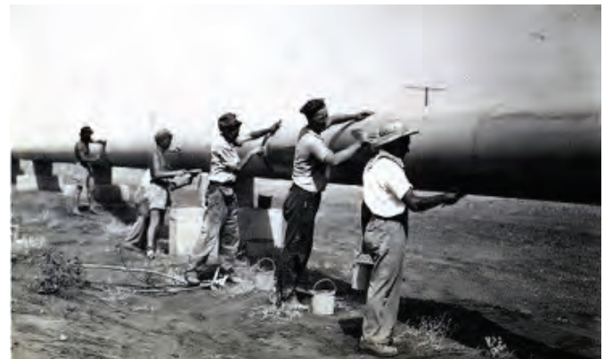
Fot. 22. Malowanie rurociągu Morgan-Whyalla
