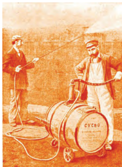
Fot. 18. Jeden z pierwszych aparatów do niskociśnieniowego, bezpowietrznego natrysku farb i impregnatów [9]
