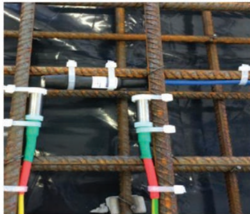
Photo 2. Installation of measuring electrodes on an object under construction Fot. 2. Instalacja elektrod pomiarowych na powstającym obiekcie
